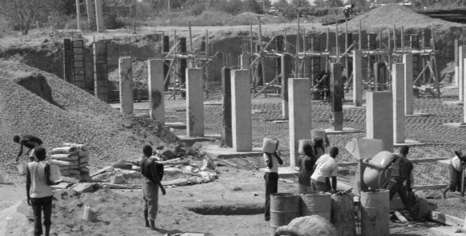
> I pilastri di fondazione dell'ospedale
